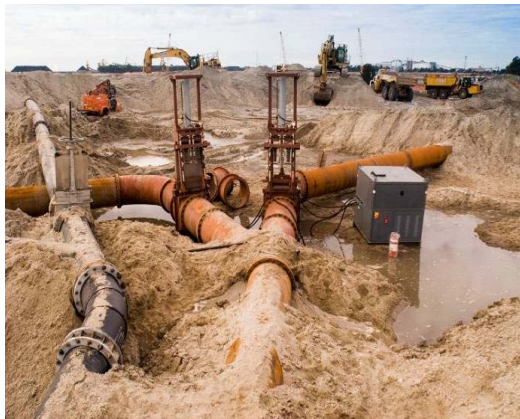
Figura 13: Interconexão (à esquerda) e instalação de tubos (à direita)
