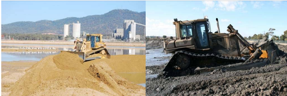
Figura 15: Bulldozer durante trabalhos de aterro
