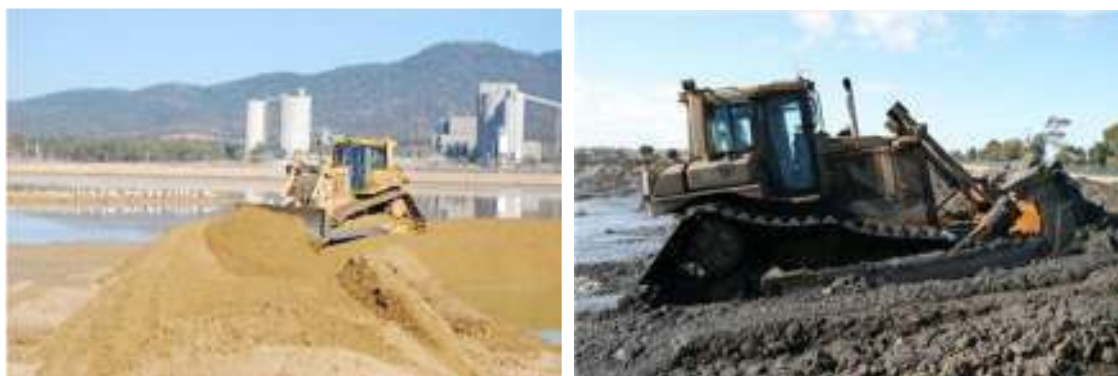
Espalhamento do material dragado com trator de rastos
