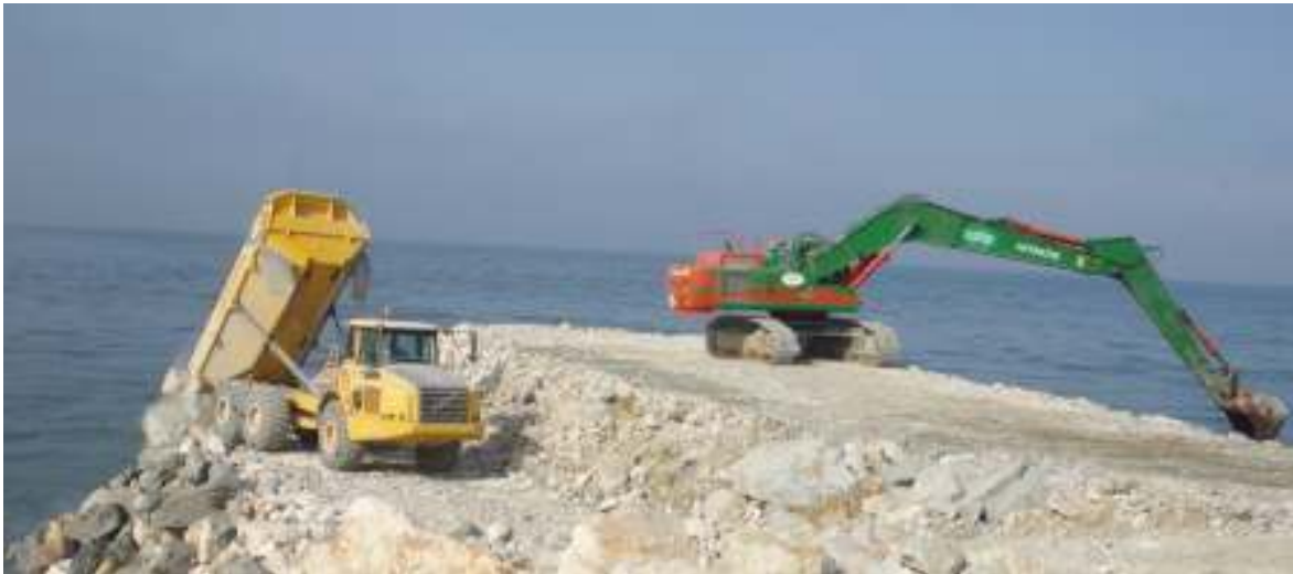
Descarga direta na construção do núcleo (Figueira da Foz, 2008)
