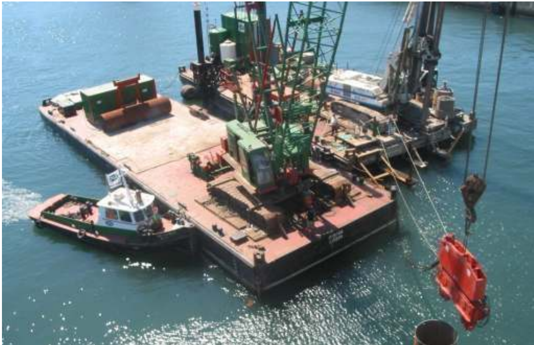
Pontão com Grua de Rastos e martelo vibratório (Leixões, 2007)
