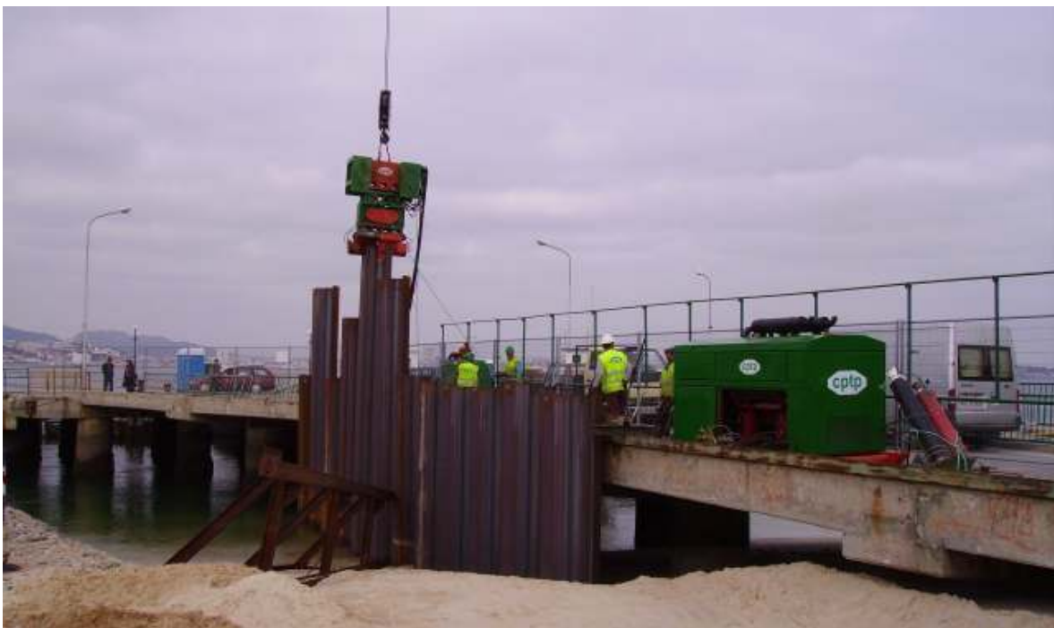
Cravação de estacas prancha com martelo vibratório (Tróia, 2006)
