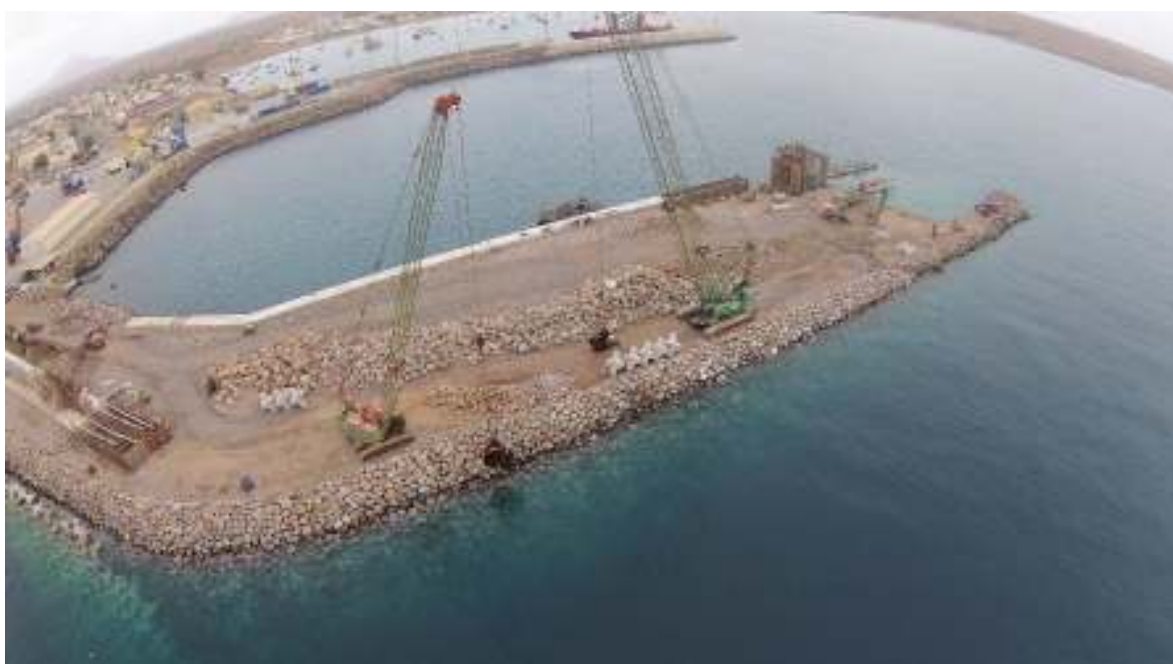
Colocação de enrocamentos com grua (Cabo Verde, 2016)
