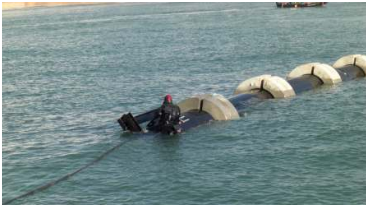
Abertura de válvula para afundamento (Albufeira, 2009)
