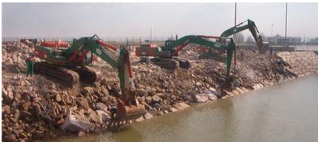
Aplicação de enrocamentos com escavadora (Costa da Caparica, 2004)
