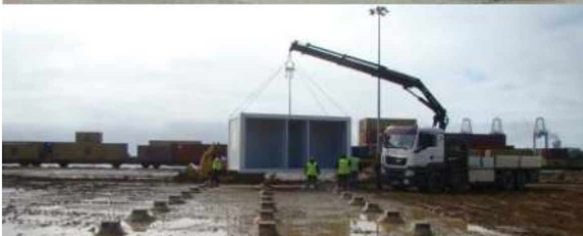
Plataforma porta-máquinas e camião-grua
