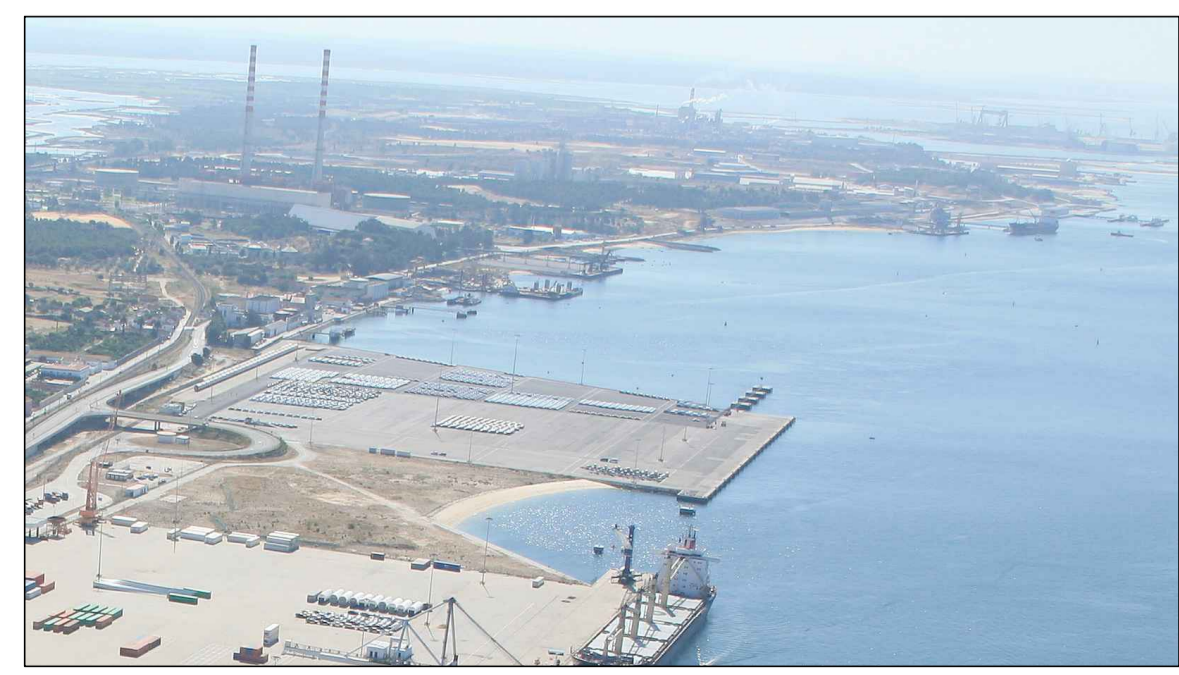
4 - Expansão do terminal Ro-Ro
