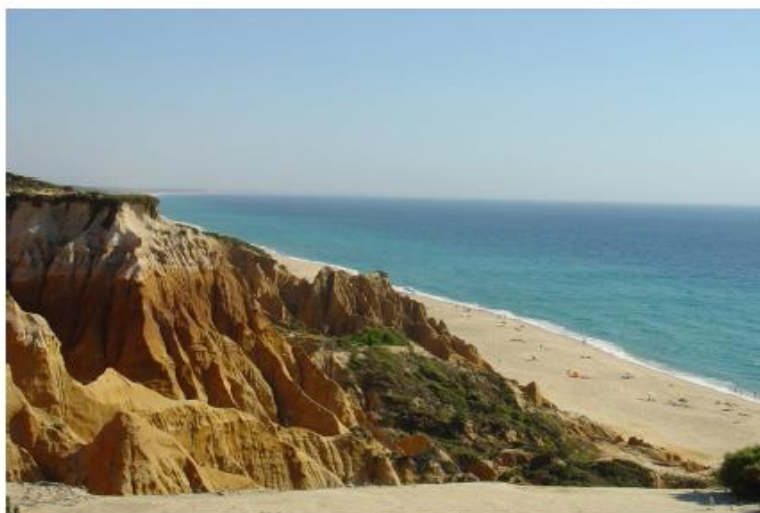
Figura 5.8 - Erosão das arribas na Praia do Barrocal (Costa da Galé)
