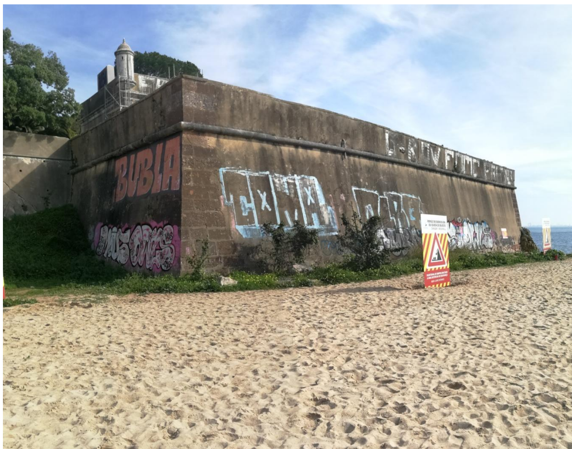
Figura 5 – Vista geral da frente abaluartada, constituído por muralhas à barbeta
