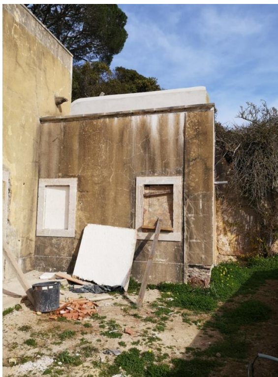
Figura 7 – Pátio posterior com construção adossada
