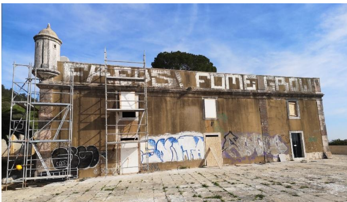
Figura 6 – Vista geral do corpo principal do edifício do Forte de Albarquel
