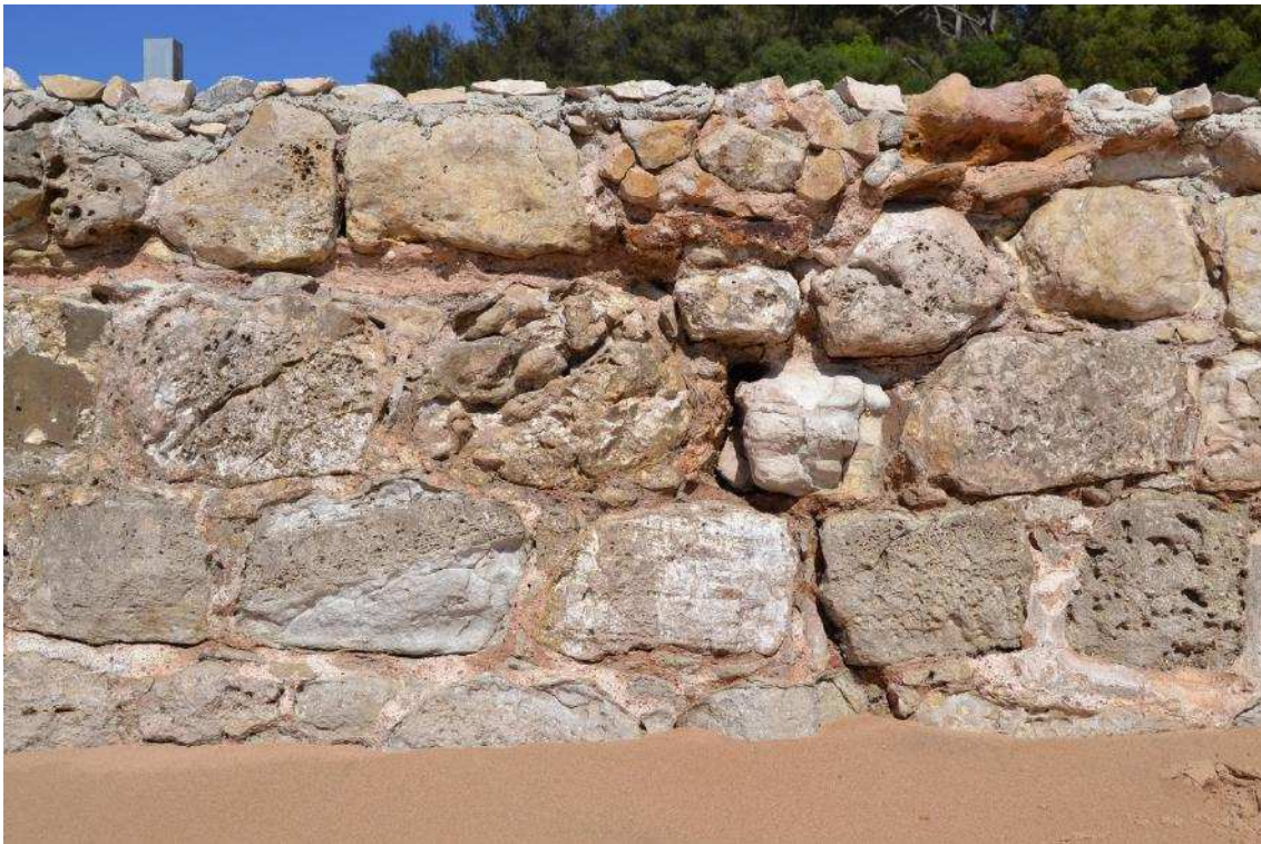
Figura 28 – Reabilitação do muro . 9 de Março de 2020
