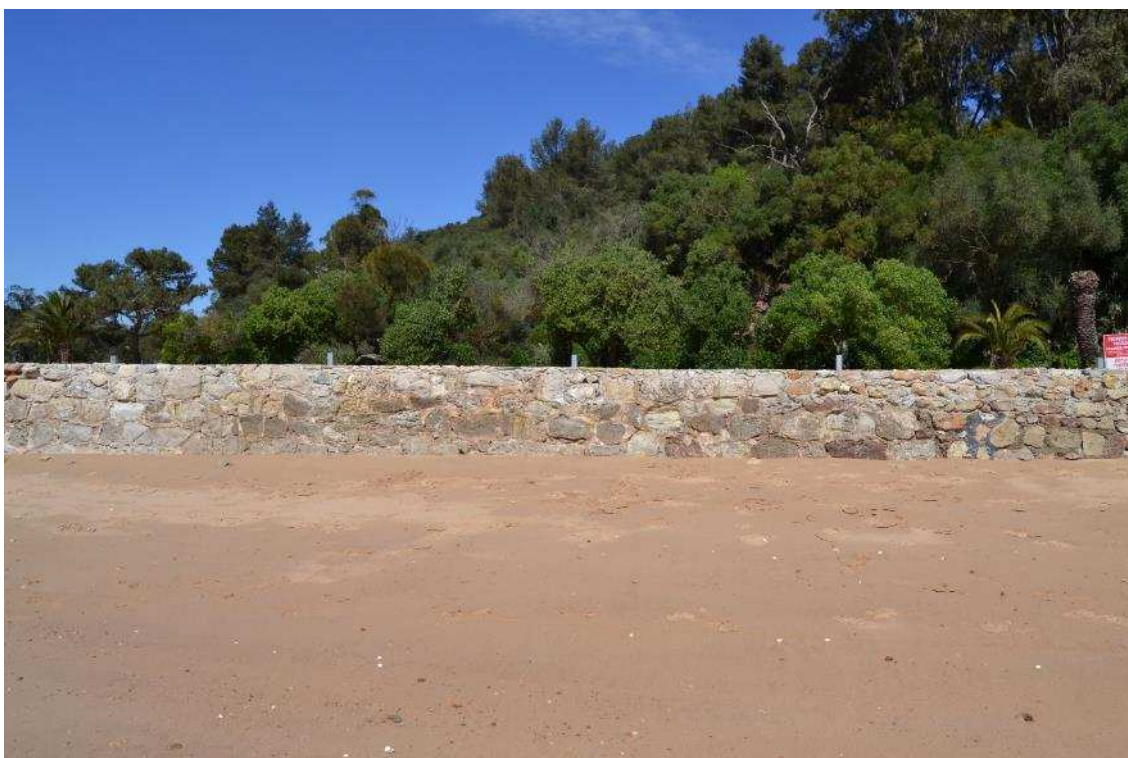
Figura 26 – Reabilitação do muro . 9 de Março de 2020
