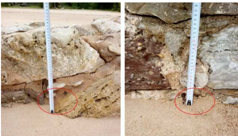
Figura 22 – Pormenor dos spits implantados, no segmento direito da imagem o ponto A e no segmento esquerdo ponto B, após terem sido realizadas as respectivas medições
