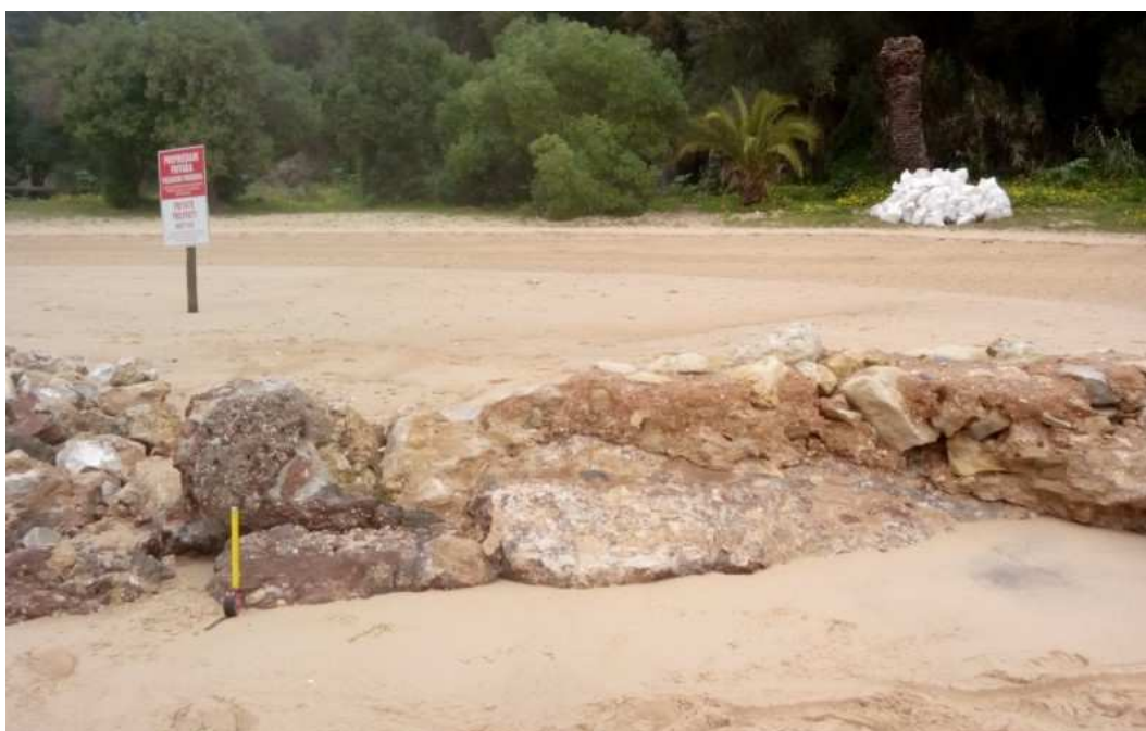
Figura 25 – Estrutura objecto de monitorização. 12 de Fevereiro de 2020
