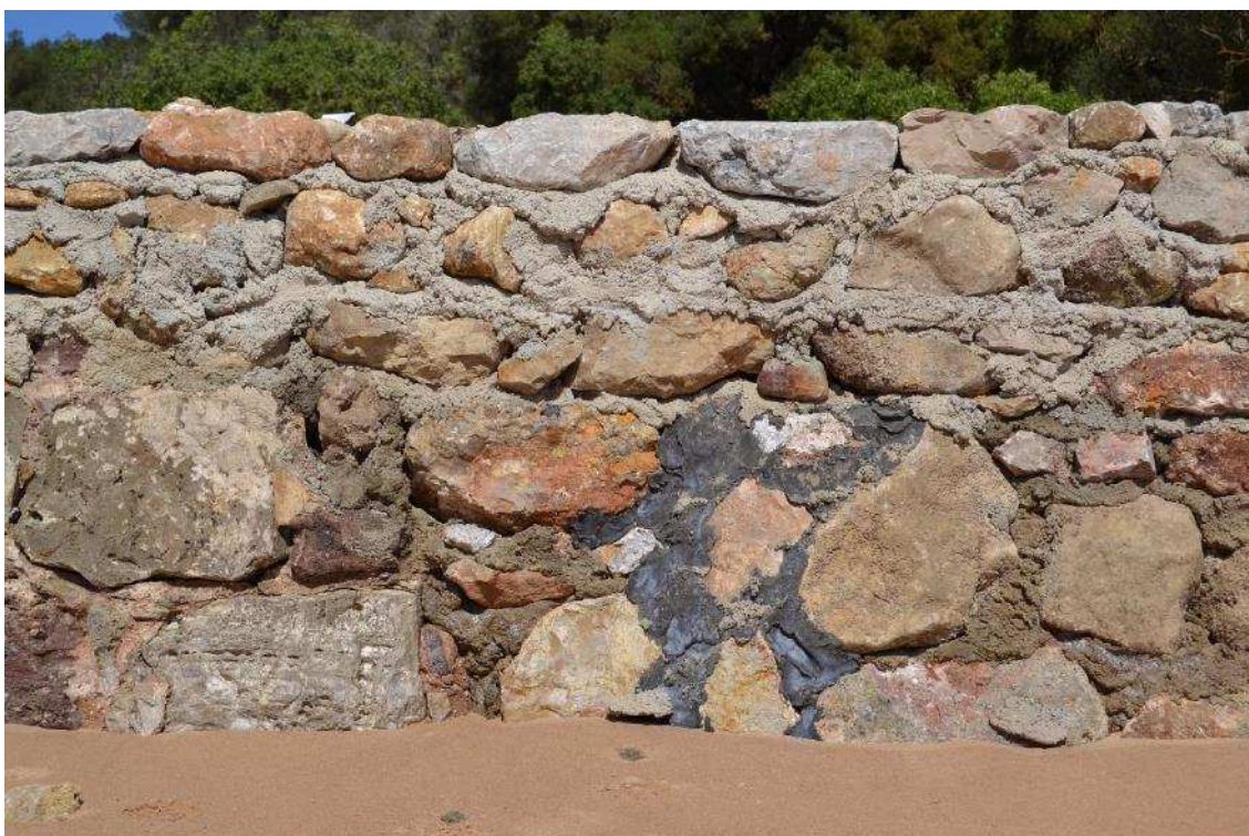
Figura 27 – Reabilitação do muro. 9 de Março de 2020
