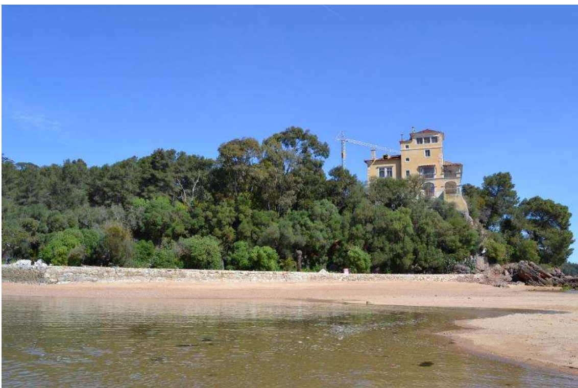
Figura 29 – Reabilitação do muro . 9 de Março de 2020
